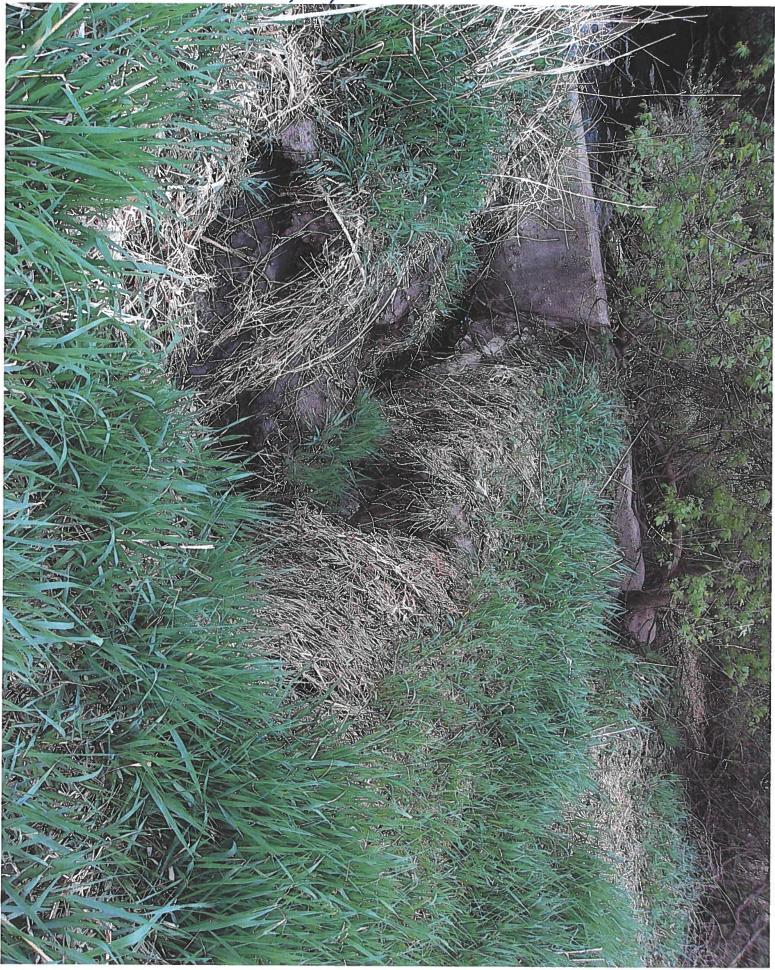
WHITER ERODING CONC. ENCASEMENT @ HEADWALL
